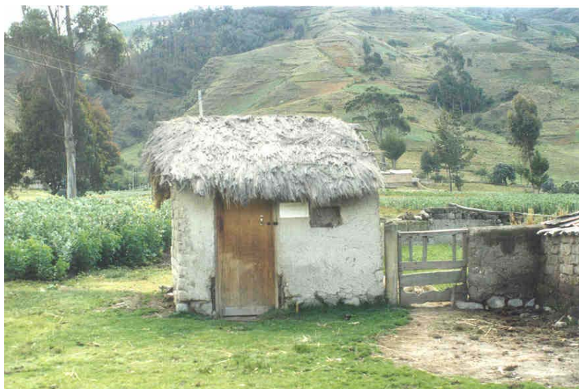
Figura 7. Almacén rústico mejorado con propósito de almacenamiento de tubérculos para consumo y comercialización
